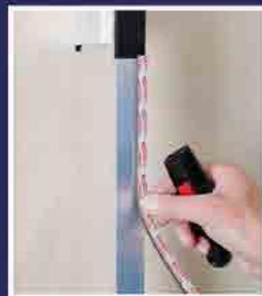
Paso 3: Colocar la cinta Foam Tape
