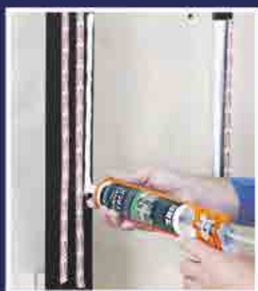
Paso 4: Aplicar el adhesivo
